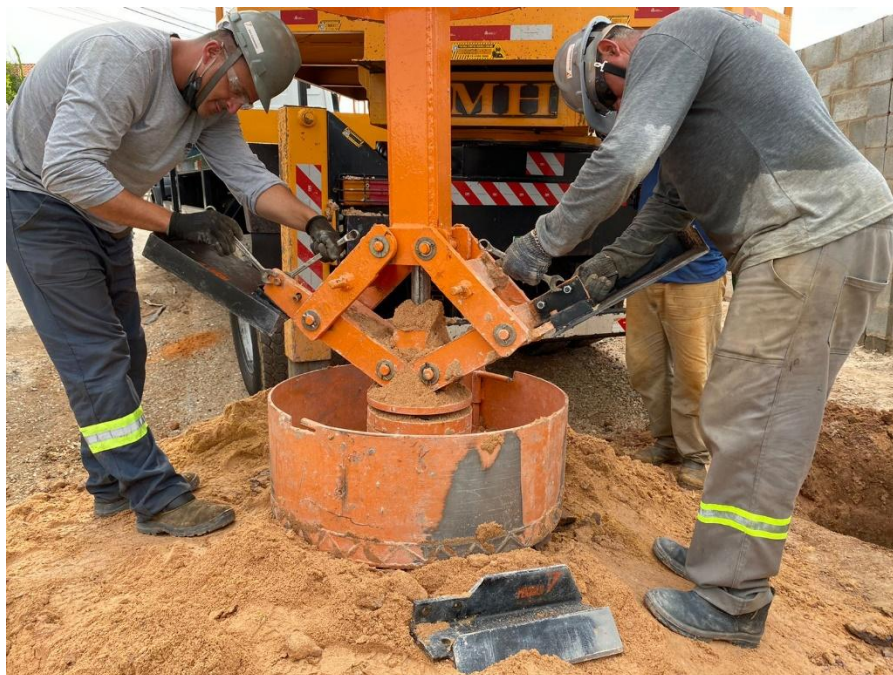
Foto 3: Pás responsáveis pela abertura da base com dimensões pré-definidas
